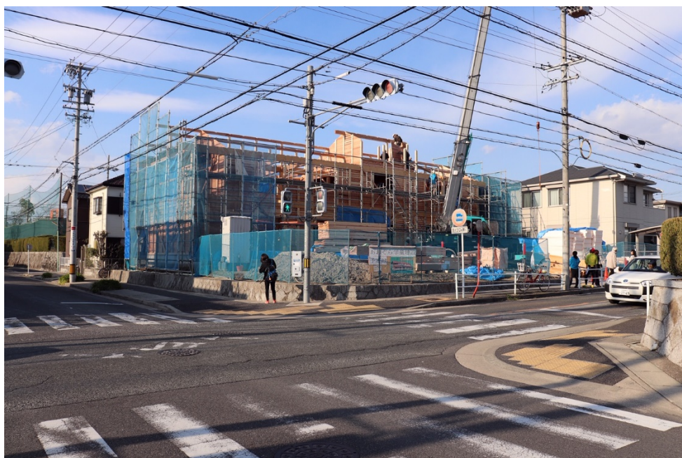
3月16日現在の建築の様子
