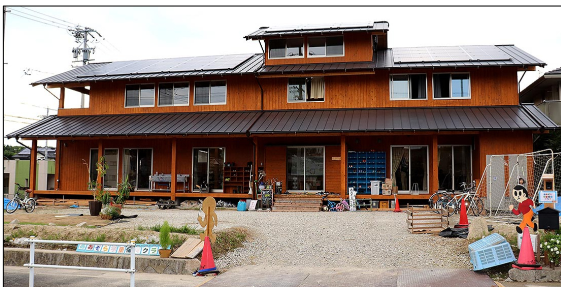
完成したあおぞら学童保育クラブ木造施設
